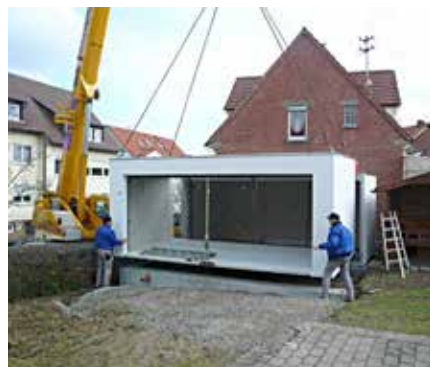
Garagenversetzung mit Kran
