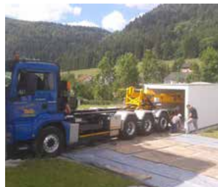
Garagenversetzung mit Versetz-Fahrzeug
