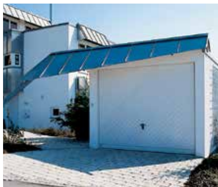
Einzelgarage mit bauseitigem Anbau
