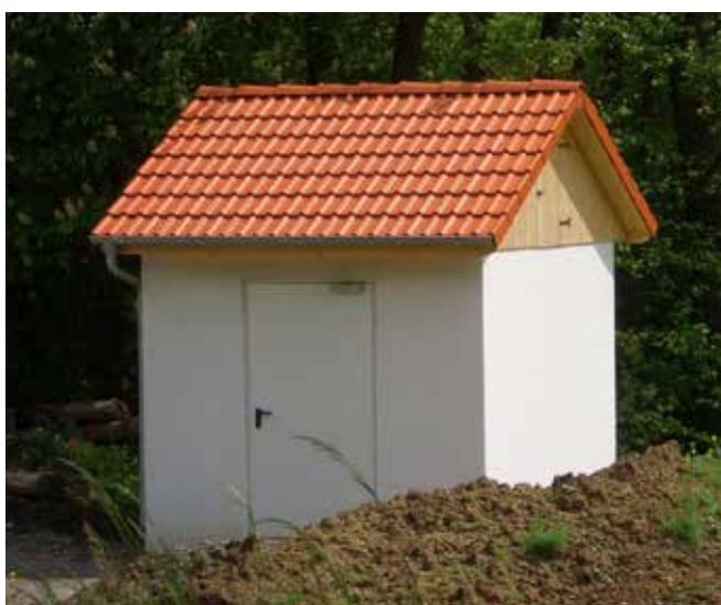
Pumpstation mit Satteldach
