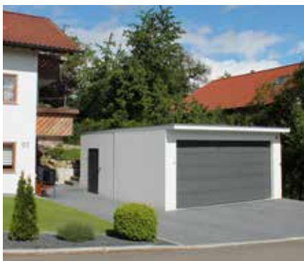
Freistehend mit Vordach
