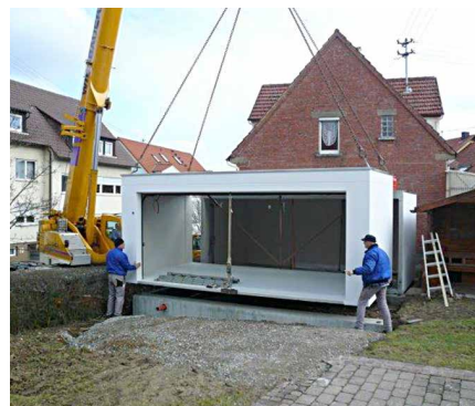
Garagenversetzung mit Kran
