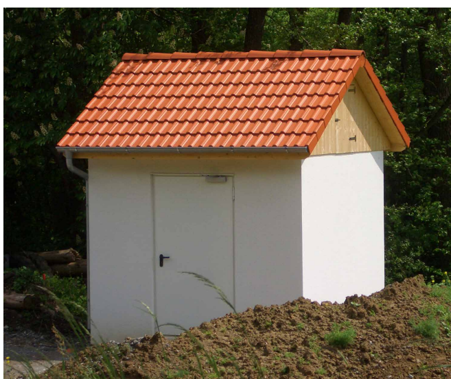
Pumpstation mit Satteldach
